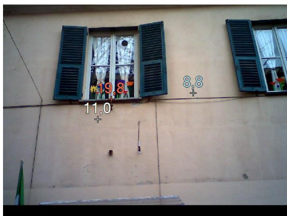
Figura 2.4 – Rilievo termografico dei serramenti
