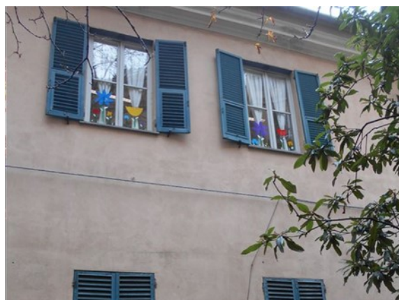
Figura 2.2 - Particolare dei serramenti
