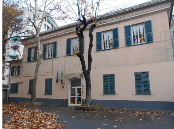
Figura 1.1 - Particolare della facciata principale
