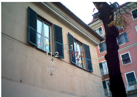
Figura 1.2 – Rilievo termografico dell'involucro
